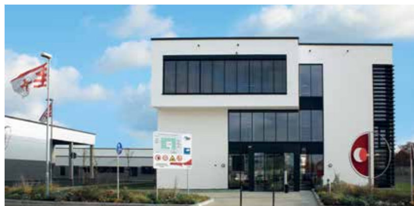
Verwaltungs- und Sozialgebäude
